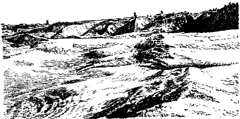
Оползни в окрестностях с. Дьякова на правом берегу р. Москвы.
