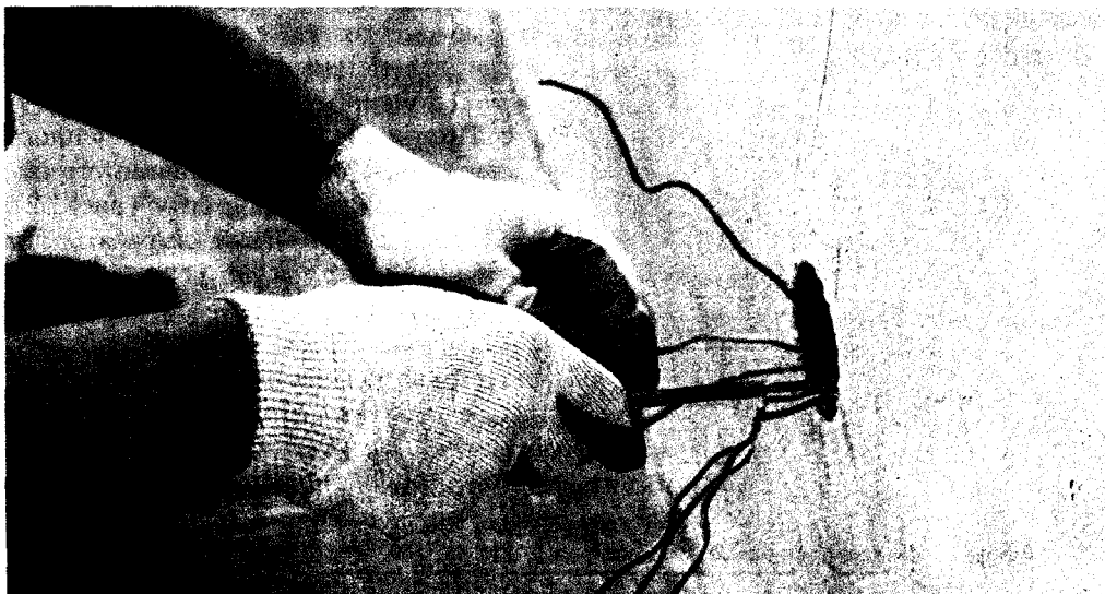
Рис. А. Чтобы отремонтировать розетку, совсем не надо быть электриком!
